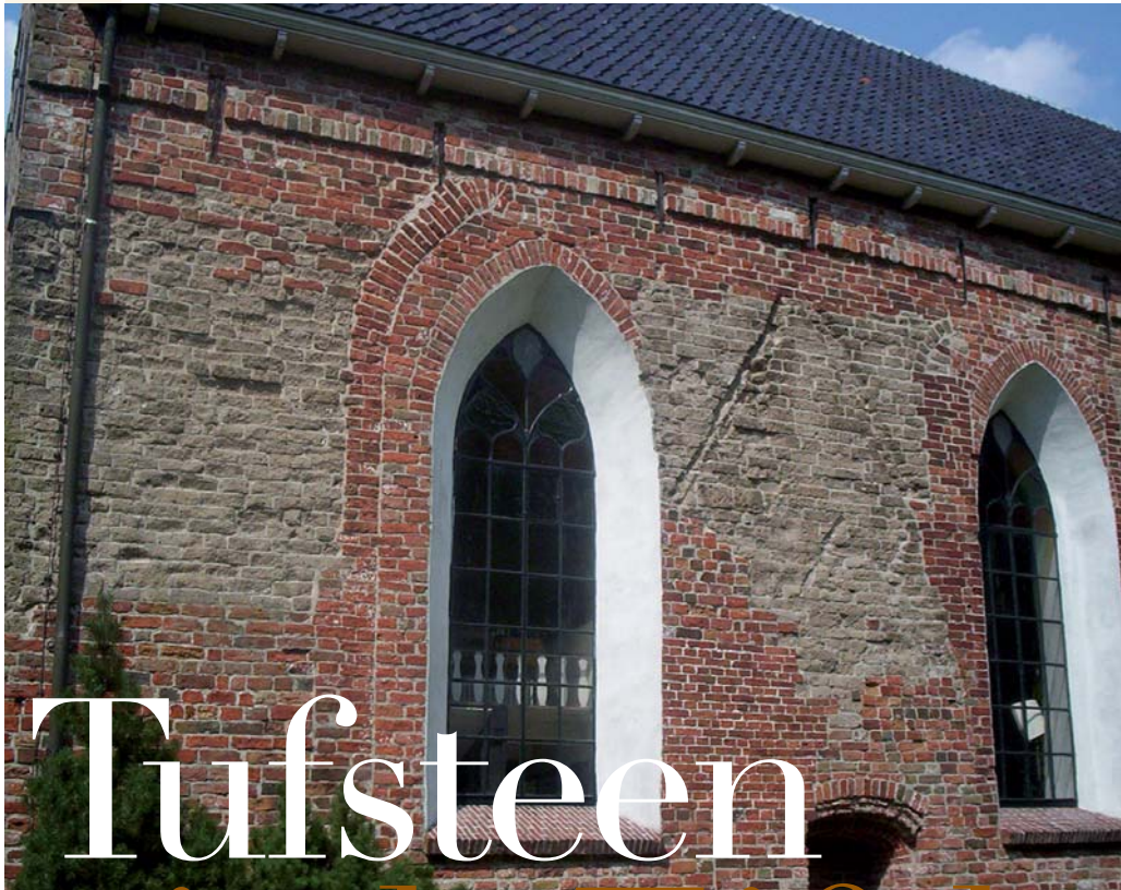
1 RESTANTEN RÖMER TUF IN BAKSTEENMETSELWERK AAN DE LAURENTIUSKERK TE BAFLO. FOTO AUGUSTUS 2004
