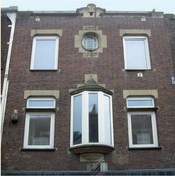
4 ETTRINGER TUF IN COMBINATIE MET RODE BAKSTEEN AAN DE UIT 1939 DATERENDE GEVEL VAN HOOGEHUISSTRAAT 13 TE EINDHOVEN. FOTO SEPTEMBER 2008
