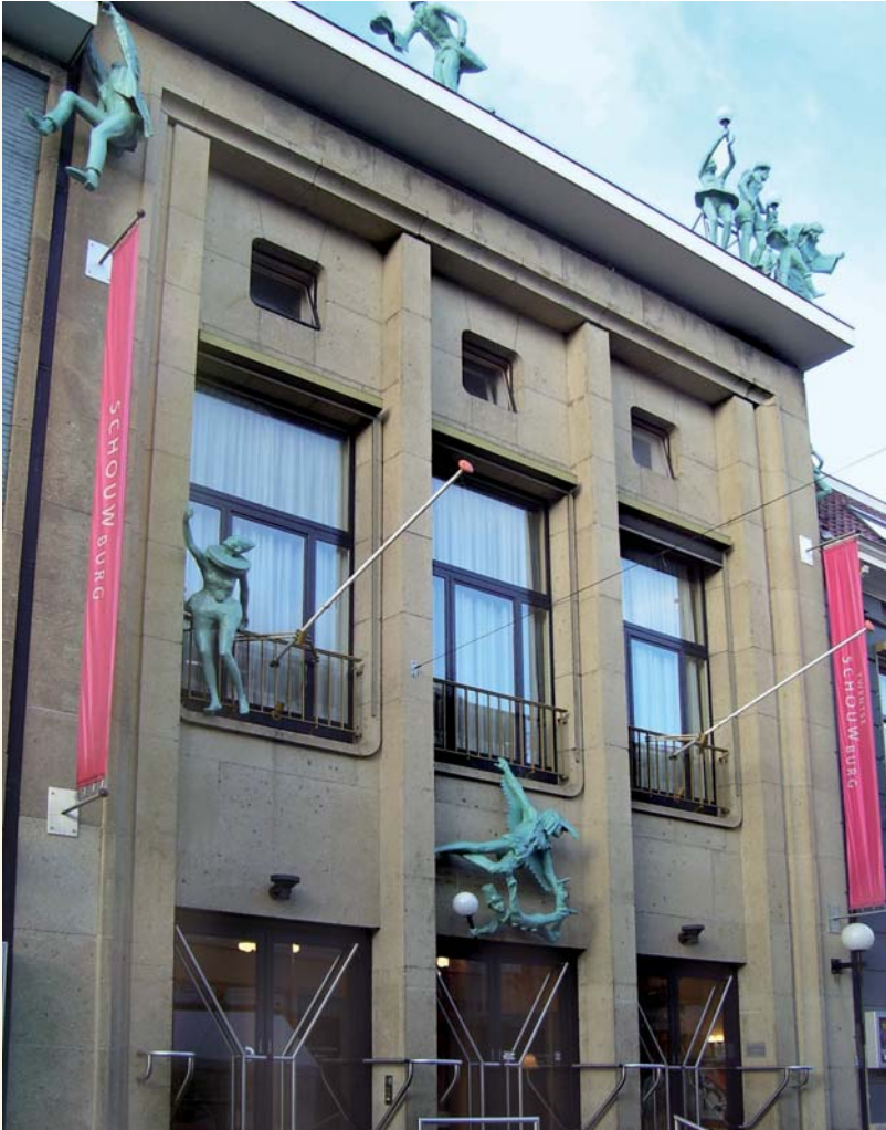
6 ETTRINGER TUF AAN DE ENTREE VAN DE TWENTSE SCHOUWBURG IN ENSCHEDE. FOTO DECEMBER 2007
