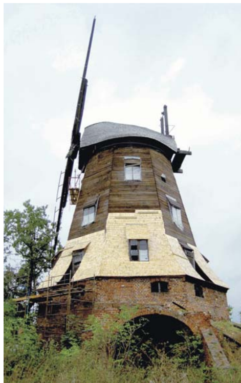
3 – DE DEELS GERESTAUREERDE BOVENKRUIER, TYPE 'HOLENDER', IN DREWNICA.
