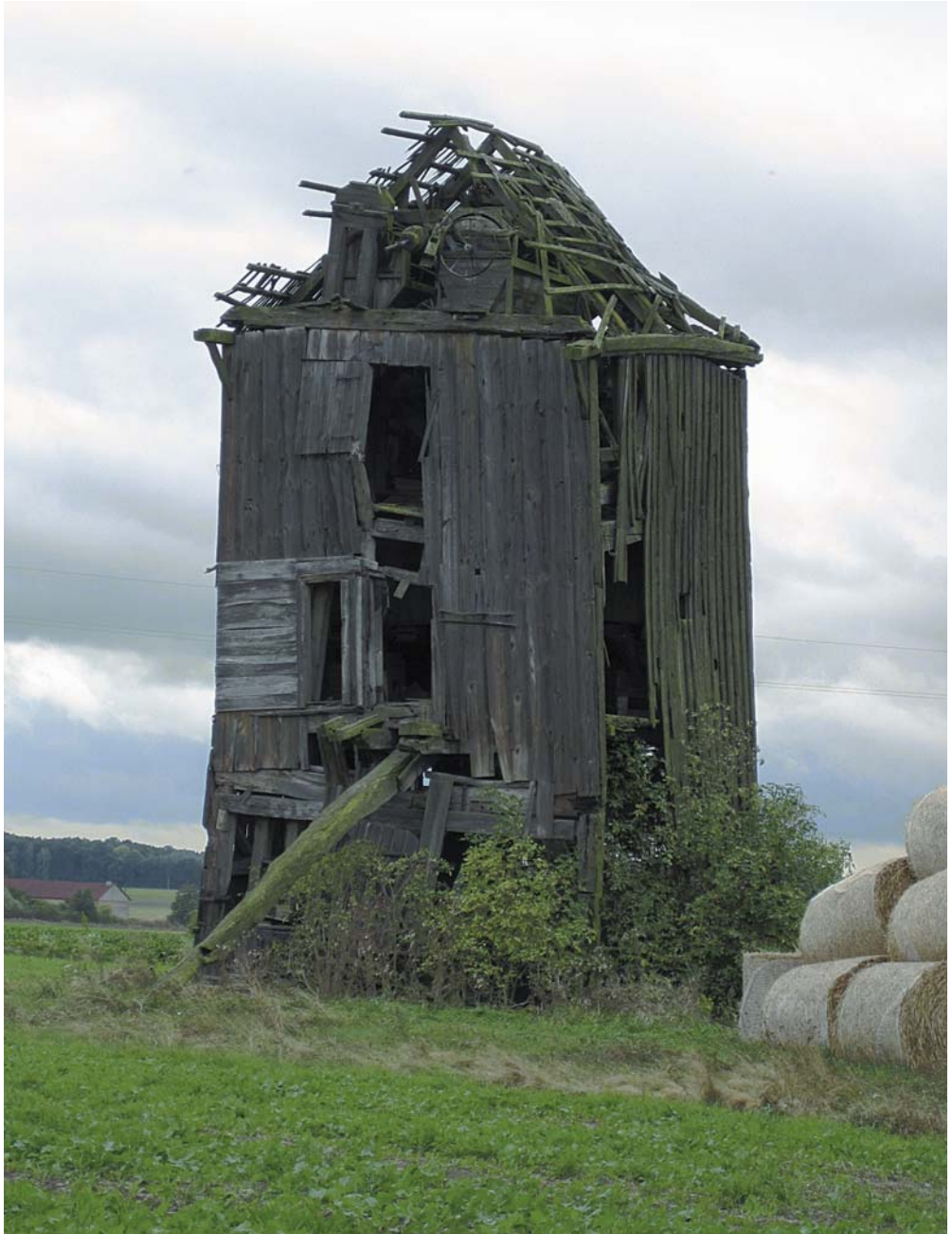
6 - DE STANDERDMOLEN TE KOTKOW IN RUINEUZE STAAT. BRON: ALLE FOTO'S DOOR GERARD TROOST
