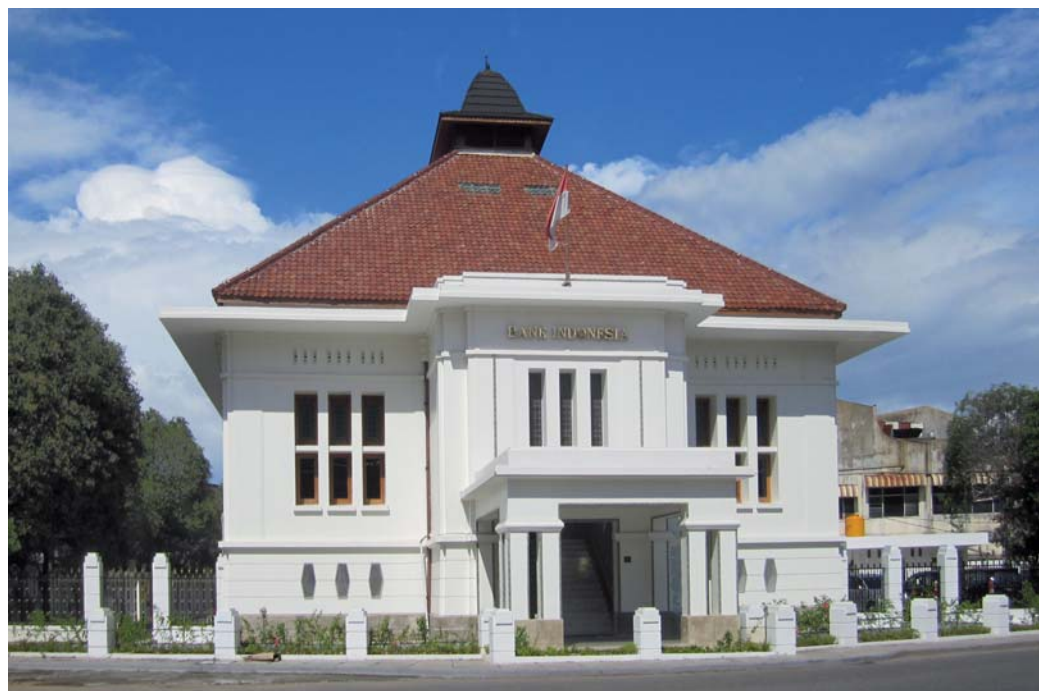
6a - b - Het gebouw van de Bank Indonesia (vroeger de Javasche Bank) in Padang, West-Sumatra, voor en na de restauratie door een expertteam van de BPPI in 2009. FOTO BPPI
