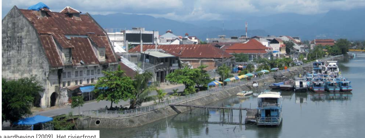
1 – De Batang Arau een jaar na de aardbeving (2009). Het rivierfront heeft veel schade opgelopen. Alleen het betonnen pakhuis links op de foto heeft de aardshokken redelijk goed doorstaan.
