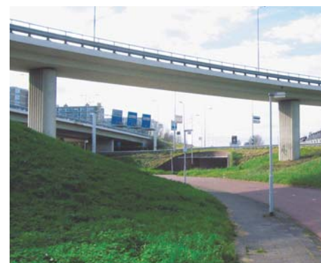
6 - HET VERKEERSPLEIN IJSSELMONDE, AANGELEGD IN 1964, IS EEN COMPLEX WAARBIJ LANGZAAM- EN SNELVERKEER VAN EN NAAR DE VAN BRIENENOORDBRUG WORDEN GELEID. FLY-OVERS, ONDERDOORGANGEN, VIADUCTEN EN OP- EN AFRITTEN CIRKELEN GRACIEUS ONDER EN OVER ELKAAR HEEN.
